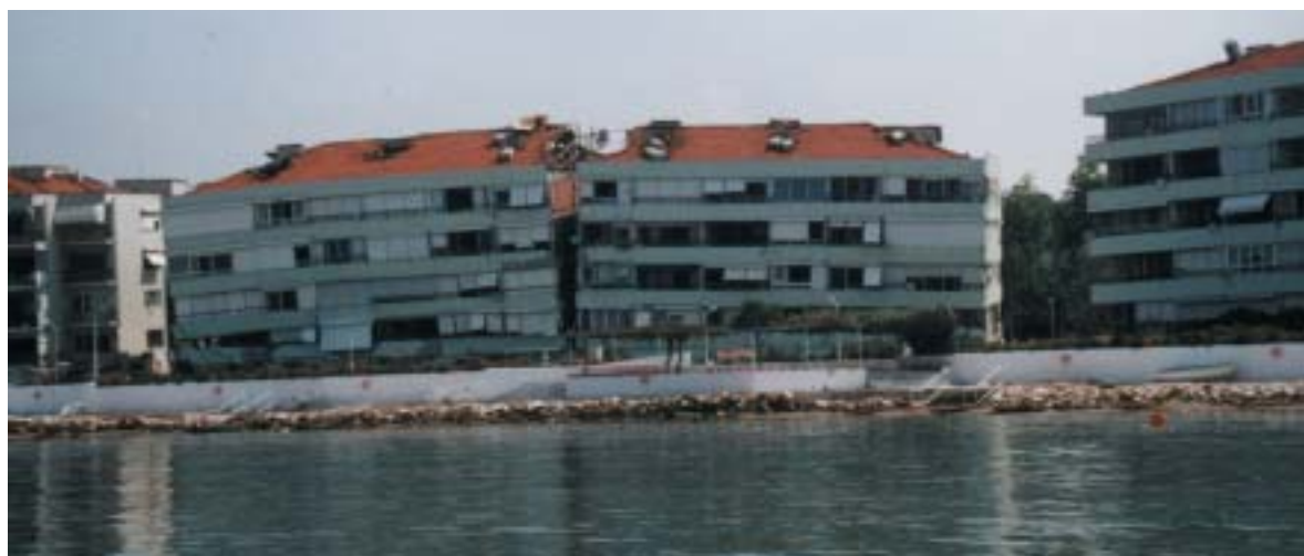
В 1999 году во время землетрясения в г. Измит (Турция) жилой дом разломился надвое
